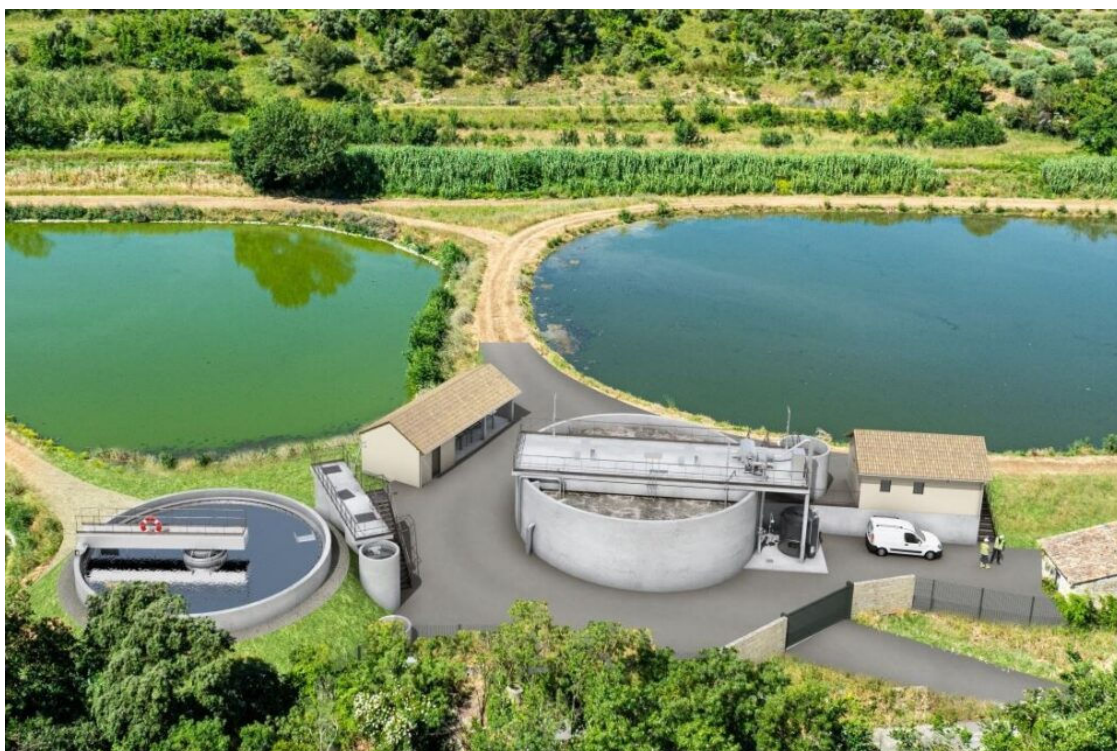
Une nouvelle station dépuración à Saint-Jean-de-Fos permettra d'obtenir une eau de qualité baignade (©SAUR)
