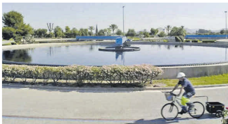
Decantadores secundarios, fase de depuración previa a la salida de planta. | Aguas de Murcia
