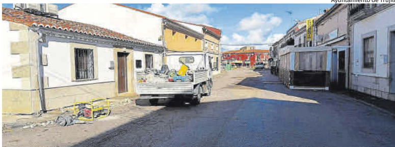
Una de las zonas donde ya se desarrollan los trabajos de renovación.
